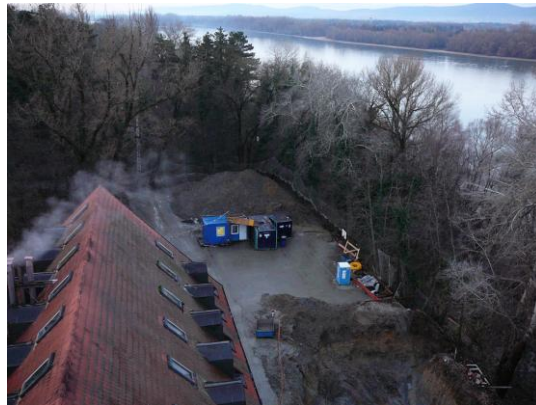
Az építési terület felülnézetből
