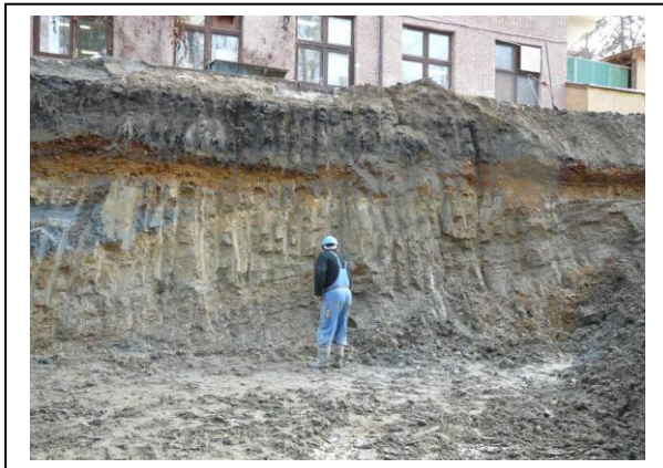
3. 4. és 5. fotó: A munkagödör falának rétegzettsége
