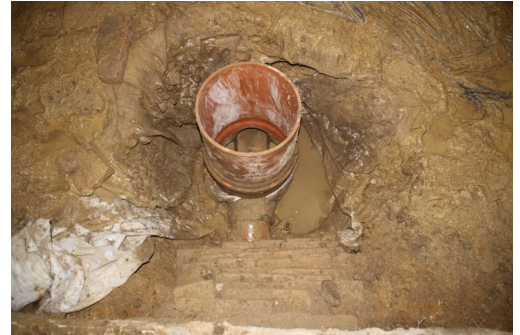
20. fotó: Kápolna alatti gyűjtőakna összefolyása feltáráskor (Felcsúti L. 2016)
